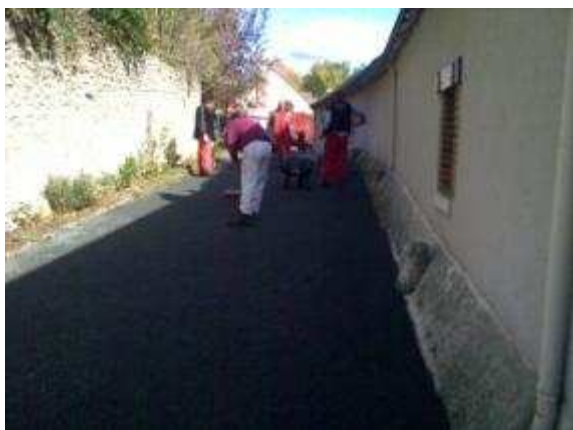
Des travaux rue du Vieux Macé, enfin !
